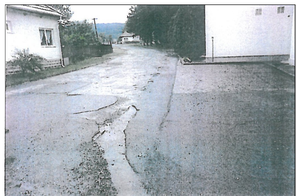
205. hrsz - volt tsz iroda melletti út
