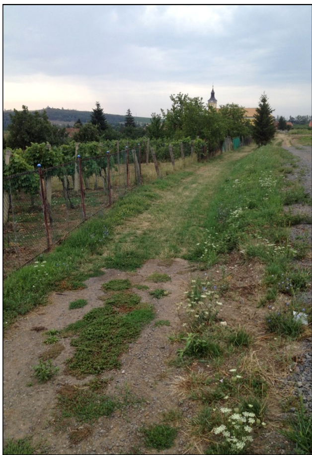
Kertek feletti út - makadám út, építése előtt
