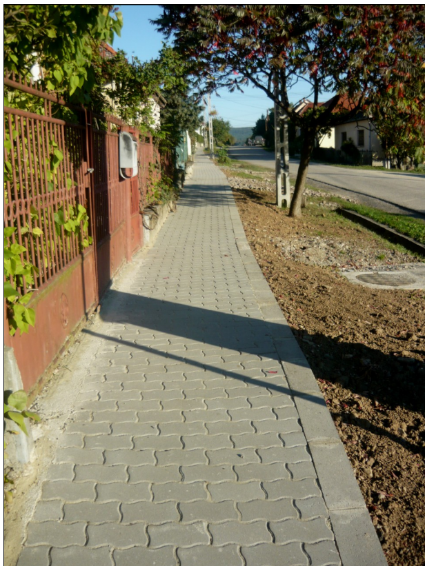
Sétány a felvégen - építés után
