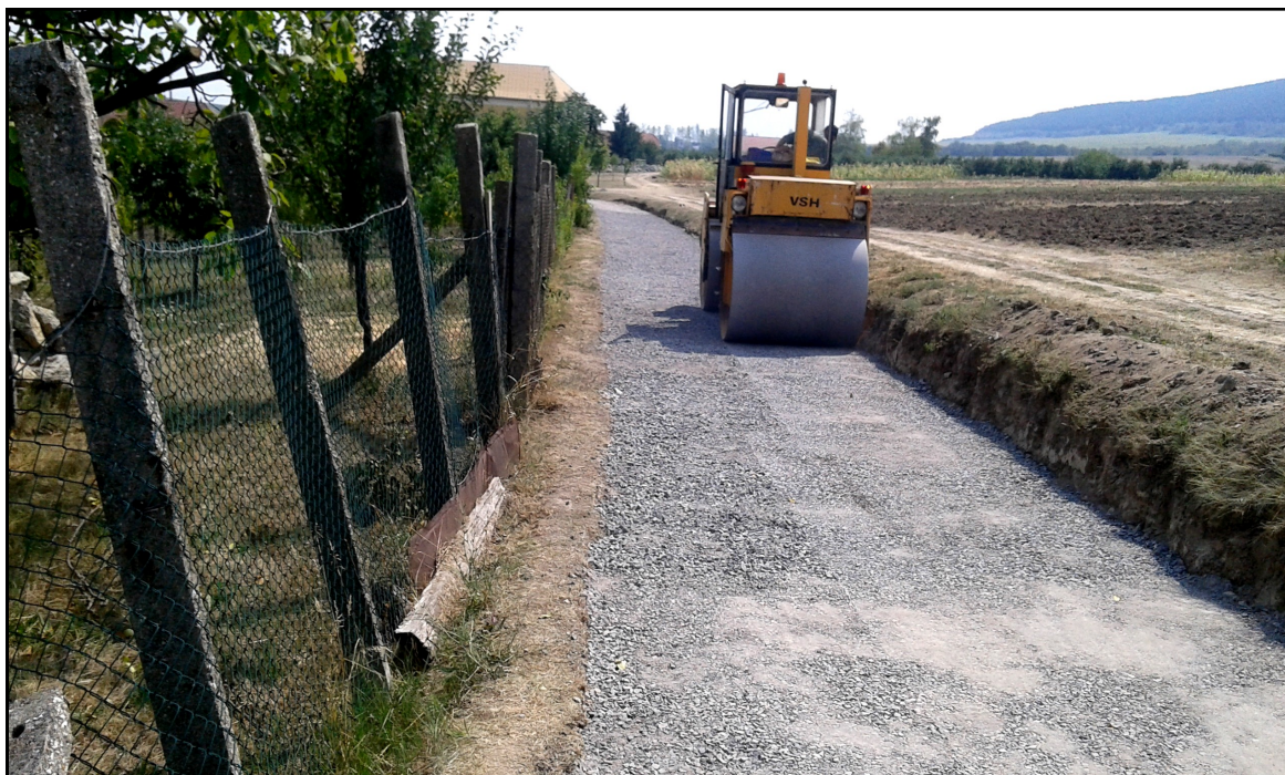
Kertek feletti út - makadám út, építés közben
