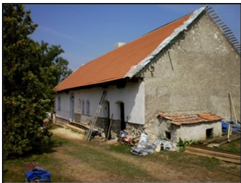
A Rátkai Sváb Tájház külső felújítása
