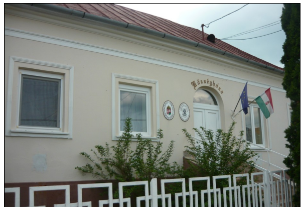
A község háza tetőfelújítása május hónapban folytatódik, ez alatt az ügyfélfogadás az épület hátsó szárnyában történik
