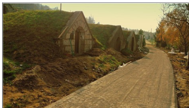
Hercegekúton októberben megépült az 1. sétány és megkezdődött a makadám utak építése
