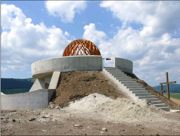
Helyére került a kupola váza és elkészült az északi kaput lezáró íves támfal
