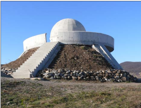
Elkészült a kupola betonburkolata és a tereprendezés a kápolna körül
