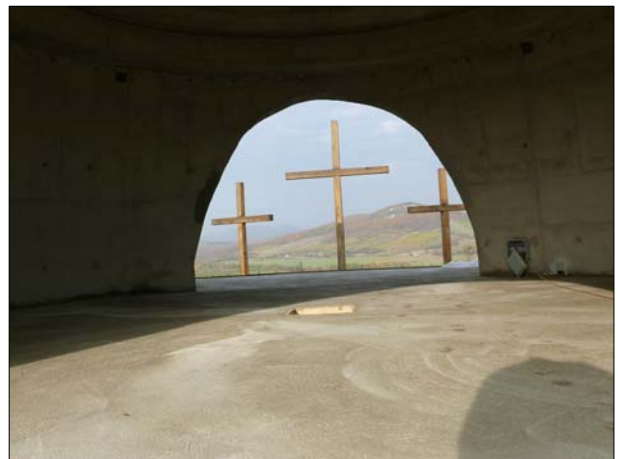
Befejeződött a kápolna aljzatbetonozása
