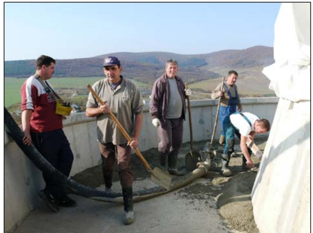
Újabb betonréteg kerül a felső teraszra
