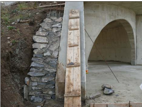
Épülnek a felső terasz vízlevezetői
