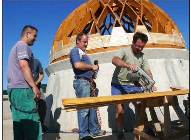
Asztalosok készítik a kupola faburkolatát
