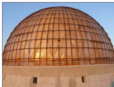
Betonvasból szerelt
